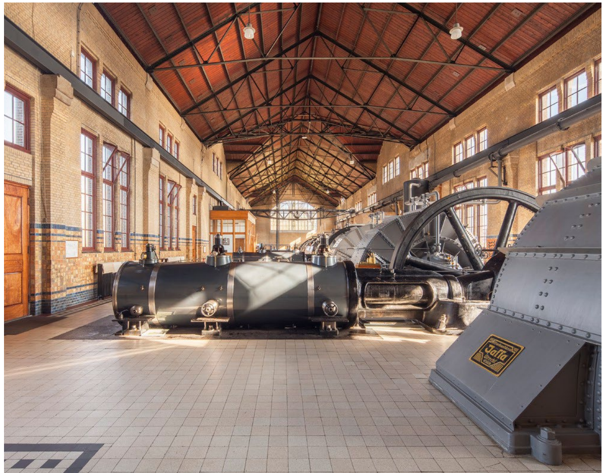
Ir. D.F. Woudagemaal • photo: Wouter van der Sar, Rijksdienst voor het Cultureel Erfgoed
